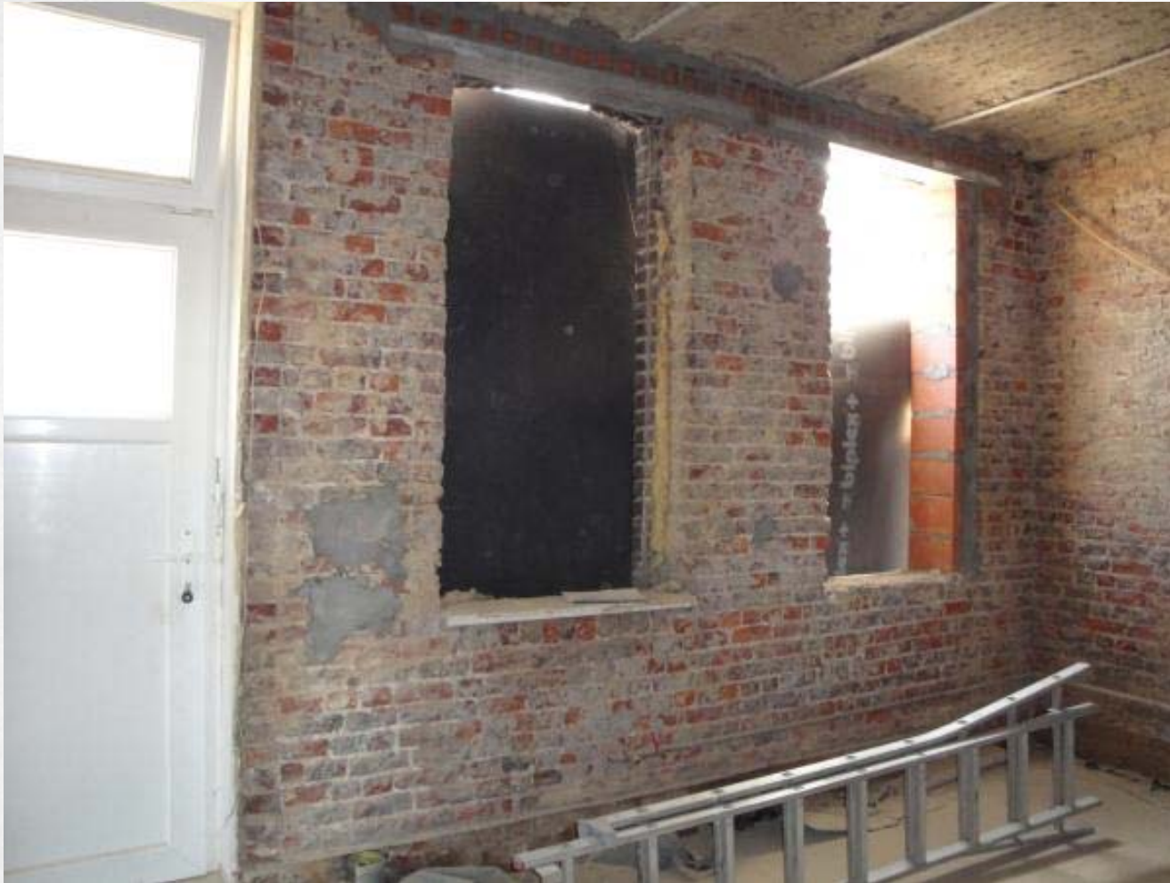
Plaatsing lintelen boven de ramen
